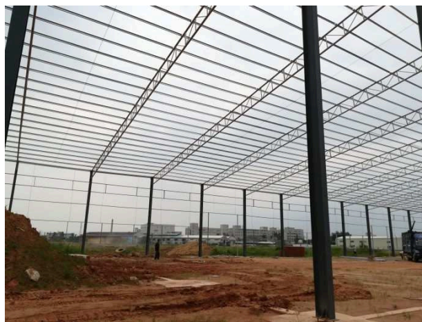
项目厂房现状
